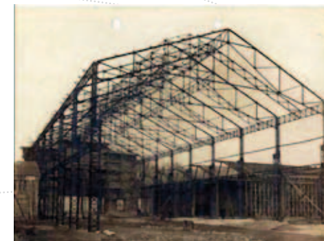
CONSTRUCTION DU HANGAR FABRE
