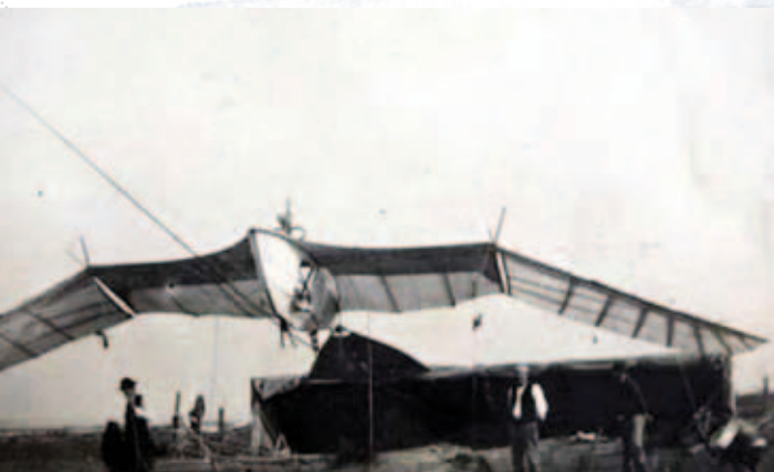
ESSAI DE L'APPAREIL DE BAZIN SUR UNE COLLINE PRÈS DE MARTIGUES
