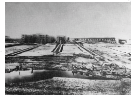
PORT-DE-BOUC : CONSTRUCTION DES CALES (1900)
