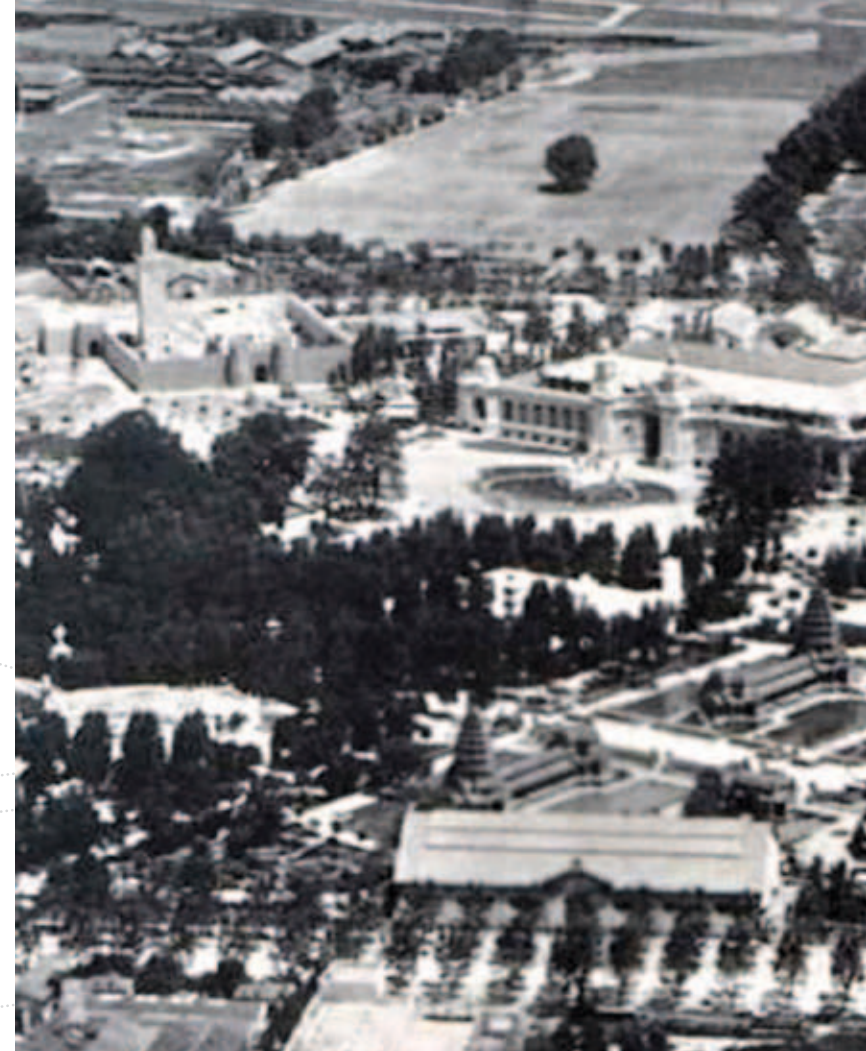
CHAMP DE MANŒUVRES DE MONTFURON (AU PREMIER PLAN LES PAVILLONS DE L'EXPOSITION NATIONALE COLONIALE SUR LE PARC CHANOT)
